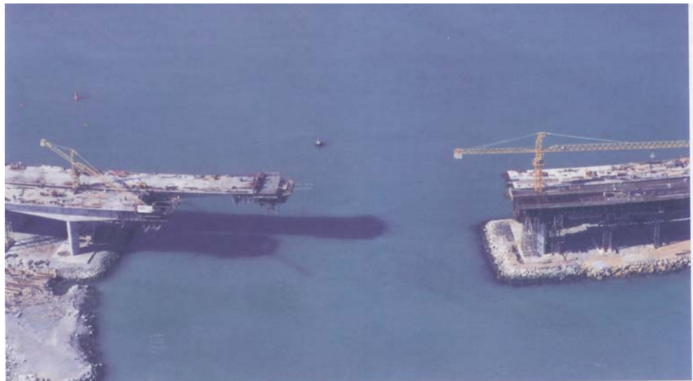
Foto 8. Construcción del vano adyacente al principal mediante cimbra convencional de torres y cuchillos. Photo 8. Construction of the adjacent span by conventional center.
