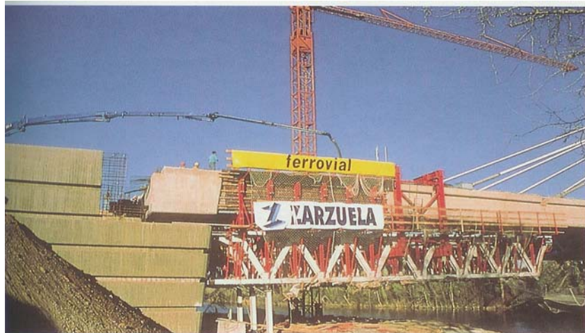
Figura 8. Llenado de la última dovela, que contacta con el diafragma de apoyo sobre el estribo de margen derecha. Figure 8. Erection of the last segment of girder, connecting with the transverse diaphragm placed over the abutment of the right bank.
