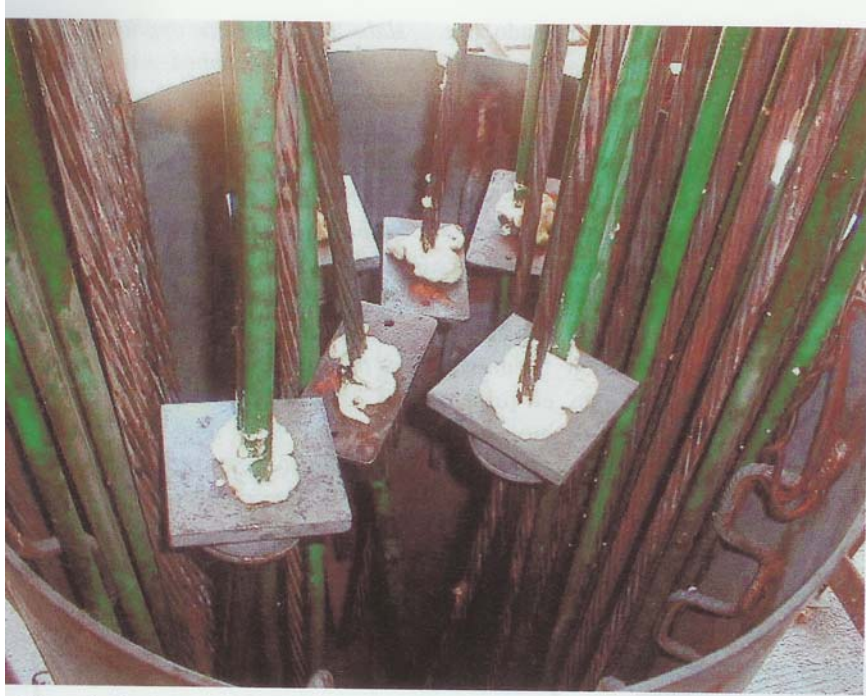
Figura 9. Cordones que constituyen un tirante. Pueden distinguirse los cordones no adherentes (envueltos en vaina, de color verde) de los adherentes (sin protección inicial). La imagen corresponde en una zona donde existe forjado, en que se han dispuesto 6 anclajes pasivos.
