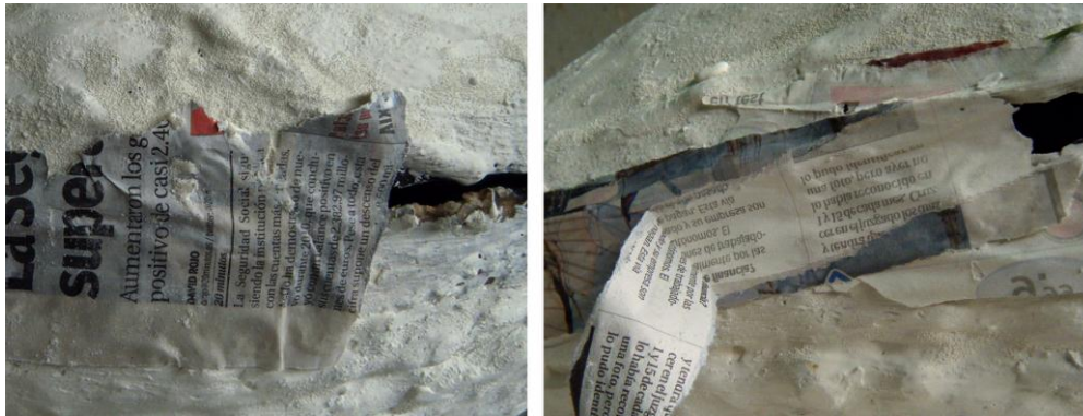
Figura III.91. Reparación realizada con papel.
