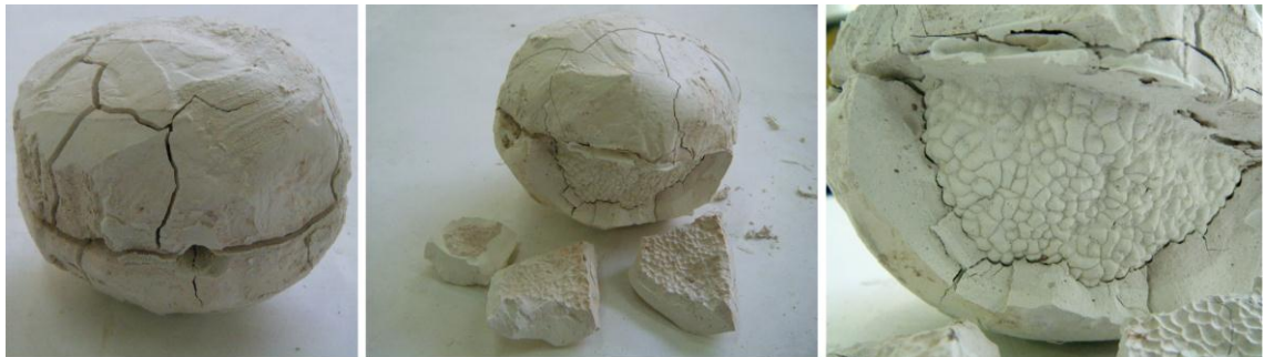
Foto III.45. Descascarillado de la escayola ya deshidratada.
