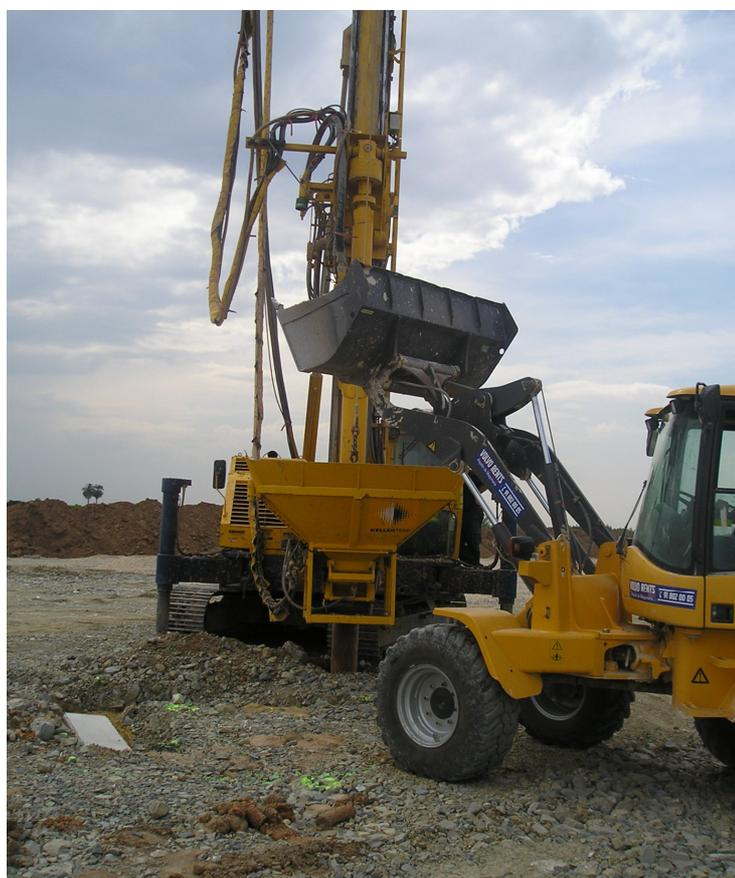
**Figura 4.8. Construcción de las columnas de grava en la Variante de Sueca**
