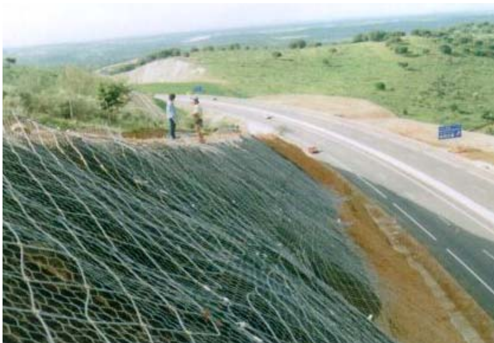
Figura 3-7. Sistema flexible PENTIFIX ® Soil Passive. Elementos componentes del sistema: Geomalla, malla de triple torsión y red de cables.
