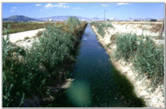
Figura 2.12. Canales en el área de la antigua Laguna de Villena, Alicante. (Foto: F.J.Oliva)
