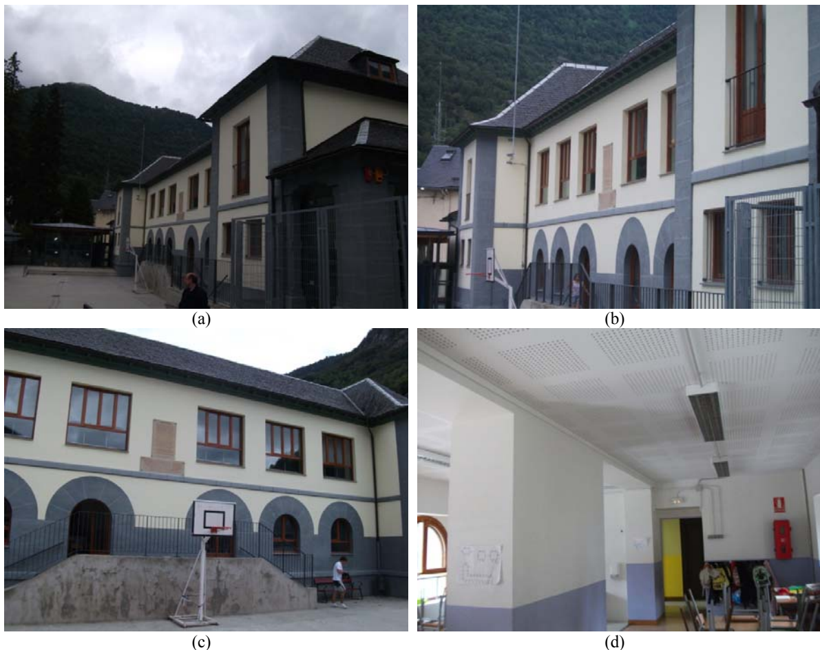
Figura 4-24 (a), (b) y (c) fachadas del edificio; (d) muros y forjado
