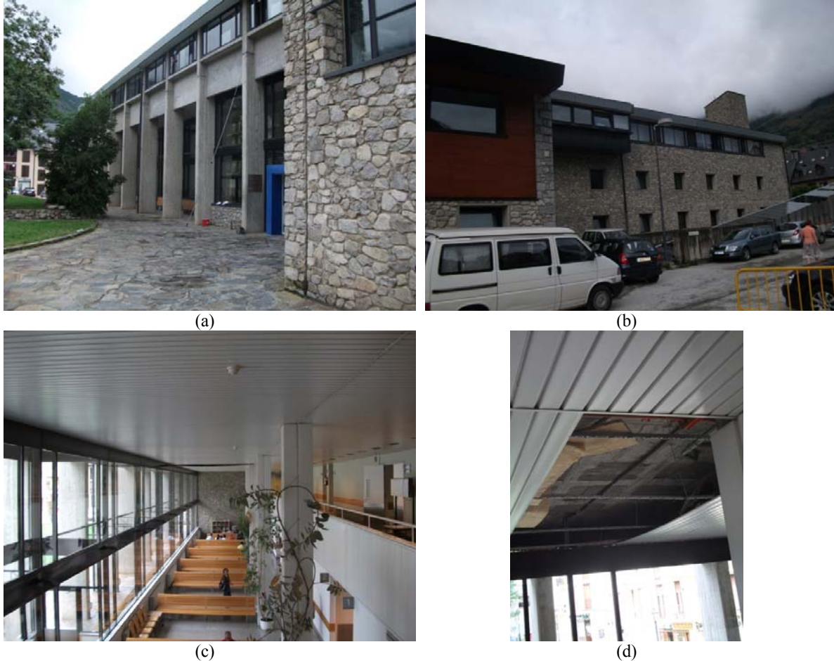
Figura 4-19 a y b, fachadas del edificio; c Pilares de la estructura; c) forjado de la estructura
