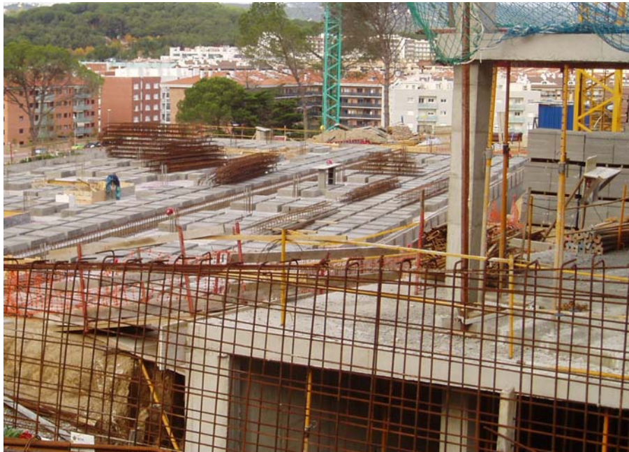
Figura A 10 Ejemplo del proceso constructivo de un edificio de hormigón armado en Cataluña. Se observa, en un primer plano, la preparación de la armadura de un muro de carga. En este caso con la misión de contener suelos. Atrás es posible observar, la preparación de forjados reticulares.
