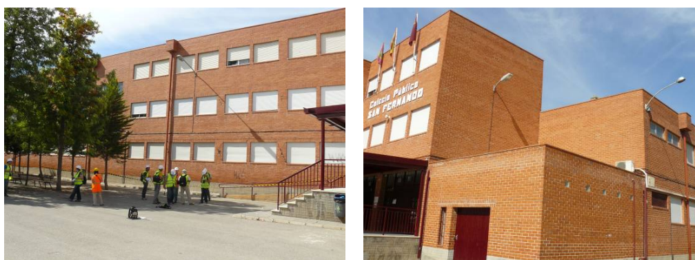
Foto C. 8 Fachadas del CEIP San Fernando
