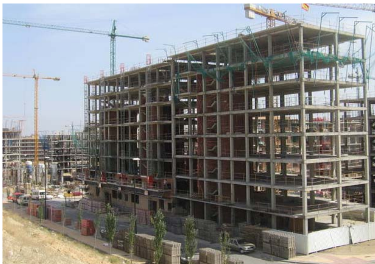
Figura A 9 Ejemplo de edificios de hormigón armado en construcción.
