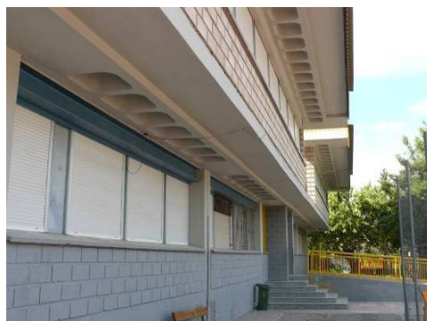
Foto C. 6 Fachada del CEIP José Robles
