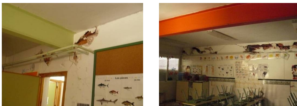
Foto C. 4 Daños en muros divisorios en la conexión entre las vigas y pilares metálicos
