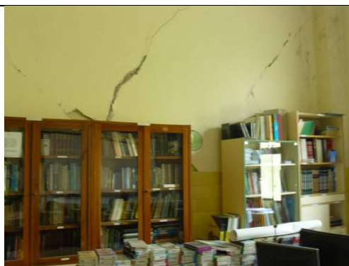
Foto C. 15 Falta de protección de elementos de mobiliario
