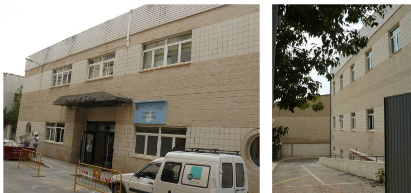
Foto C. 25 Fachadas del Centro de Salud Lorca - Centro
