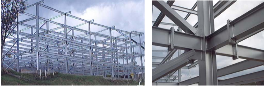
Figura A 12 Construcción de un edificio metálico y detalles de la conexión viga-pilar.
