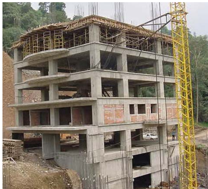
Figura A 11 Ejemplo de un edificio de hormigón armado de México.
