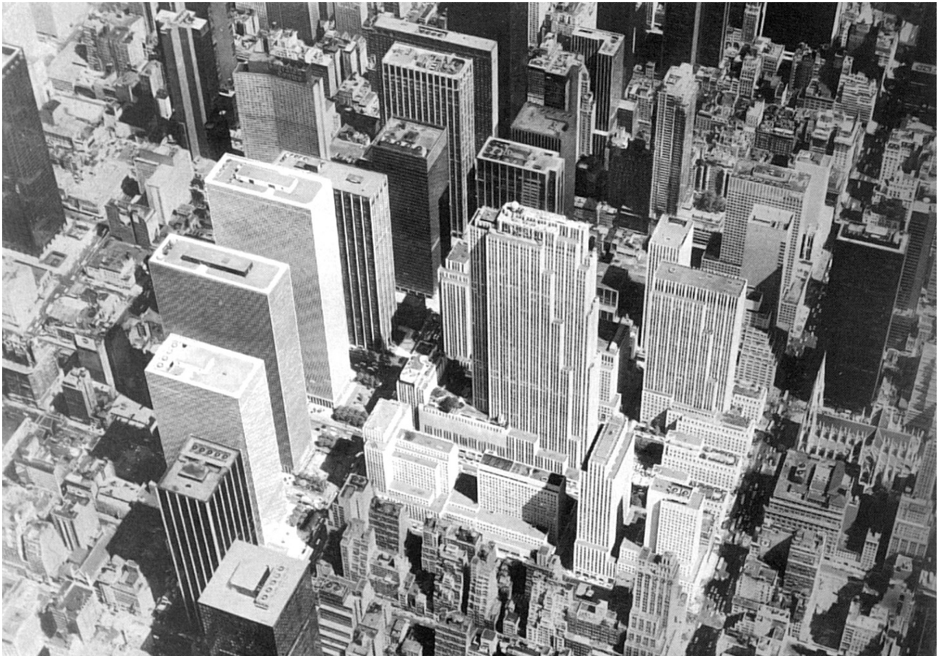
19. Perspectiva aérea del complejo Rockefeller Center y los nuevos edificios de remate de manzana de la Sexta Avenida. Se destaca también la variación de escalas en el mismo entorno.
