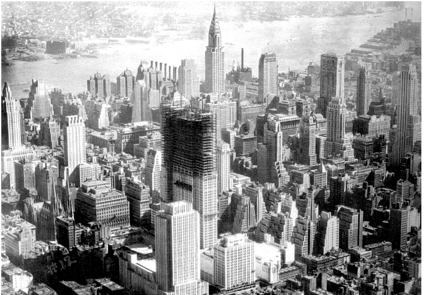
22. Perspectiva aérea del complejo de edificios Rockefeller Center hacia el sureste. Se destaca la torre principal, todavía en construcción, y la ausencia del International Building.
