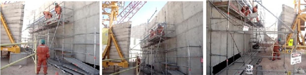
**Figura 21 Colocar planchas de acero y rodapiés**
