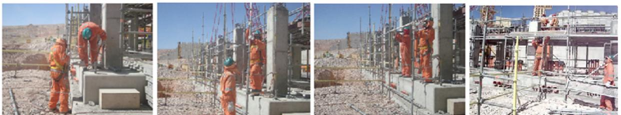
**Figura 24 Secuencia de colocar bases regulables, horizontales, verticales, Diagonales y horizontales "U" reforzadas, placas de acero.**
