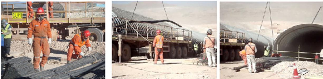
**Figura 57 Secuencia Carga y descarga de camión. Asistencia a camión grúa**
