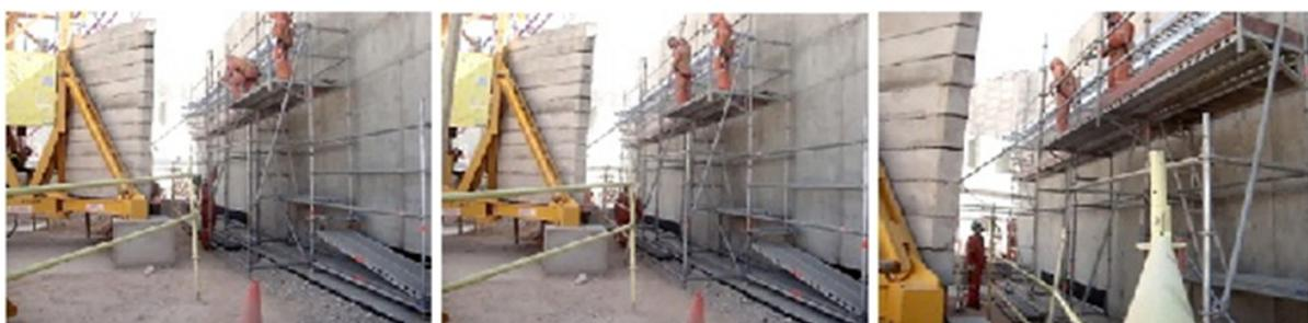
**Figura 19** Secuencia Colocar barras verticales y horizontales
