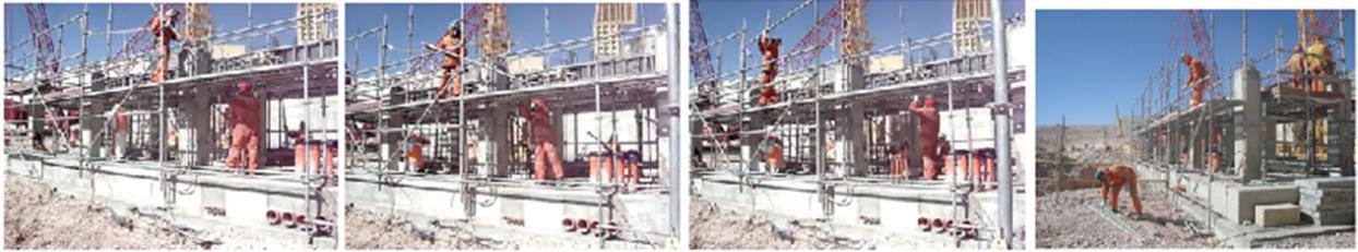
**Figura 25 Secuencia de colocar verticales, horizontales, horizontales “U” reforzada, rodapiés, otros.**
