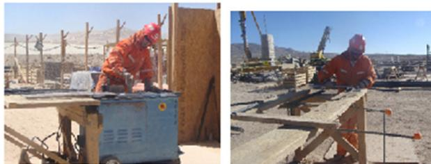
**Figura 8 Banca, máquina de doblado y machina.**
