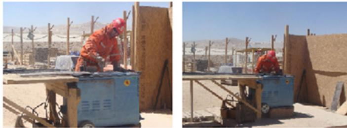
**Figura 53 Preparar máquina para tipo de doblado**
