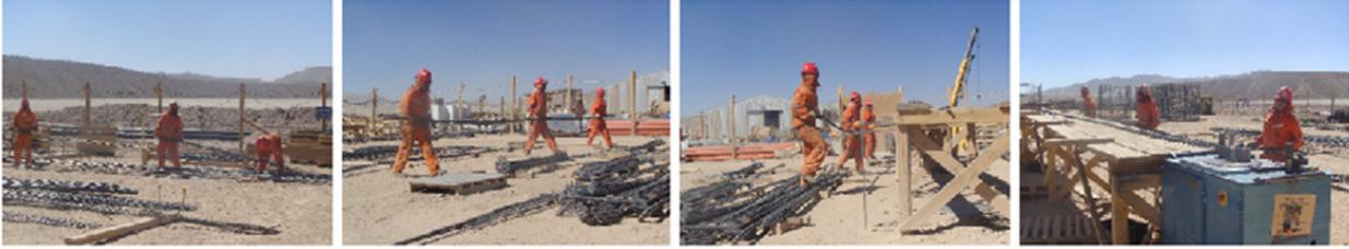
**Figura 54 Transportar fierro desde zona de corte a Banca de doblado**
