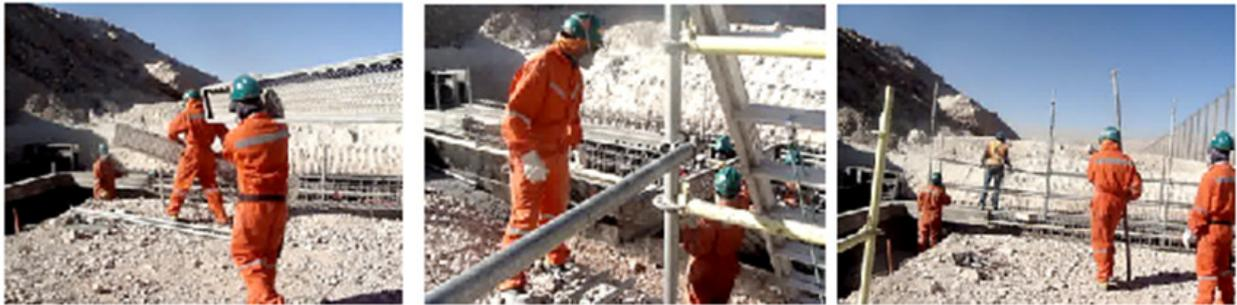
**Figura 36 Montaje de andamio en Terminal**
