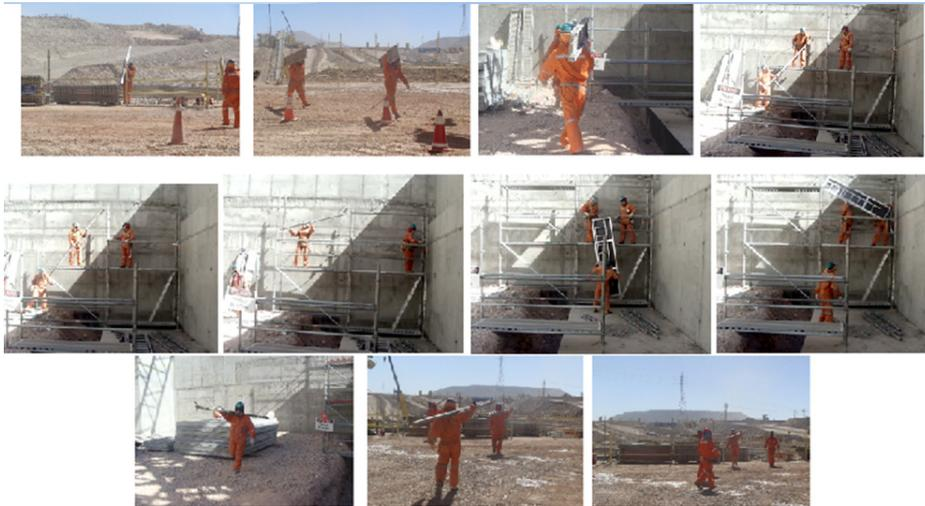
**Figura 26 Montaje Andamio Zona Chancador 2-3. Secuencia completa**
