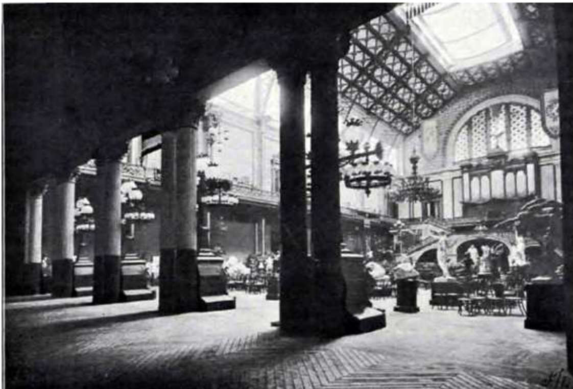
Interior del Palau de Belles Arts, des del vestíbul d'entrada: s'aprecia el gran saló central, cobert amb la claraboia i en el fons l'escala monumental sota l'orgue (foto Audouard, Album Salón , núm. 20, 16-6-1898)
