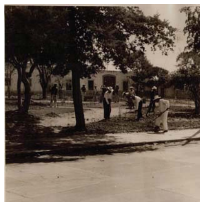
Gráfico 90.-Obras de construcción del jardín Los Remedios por la Dirección de jardines de paseos y jardines del H. Ayuntamiento.
