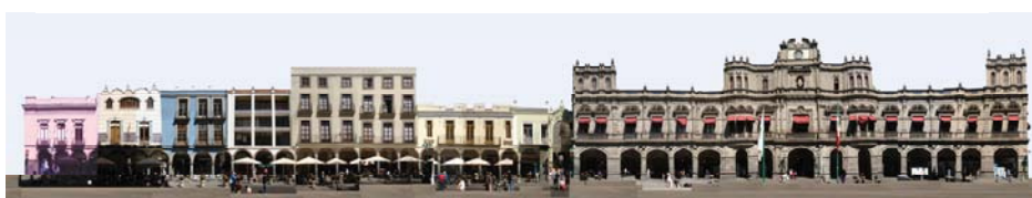
Gráfico 254.- Estado Actual Portal Hidalgo: En este la Primera parte antes de llegar al Pasaje la invasión es una constante hacia el lado del Palacio del Ayuntamiento la libre circulación caracteriza el trayecto. Larguillos fotográficos elaborados por la autora
