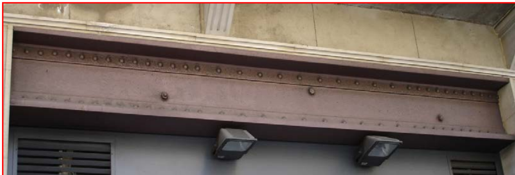
Figura 2.21 Detall unió cargolada i reblonada. Autoria personal.
