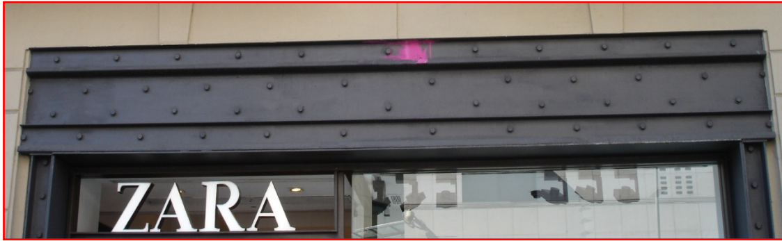
Figura 2.15 Detall unió cargolada. Autoria personal.
