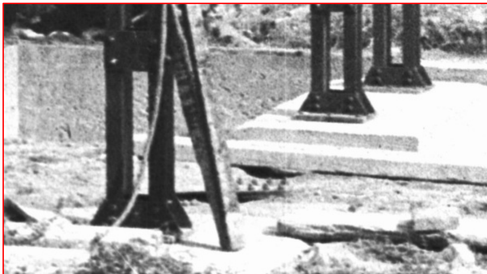
Figura 2.32 Unions. Casa Bloc 14 . Dècada dels anys 30.
