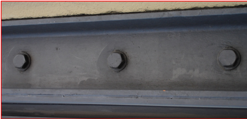
Figura 2.18 Detall unió cargolada. Autoria personal.
