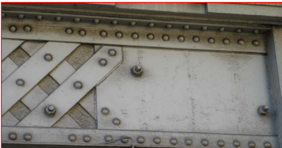
Figura 2.28 Detall unió cargolada i reblonada. Autoria personal.
