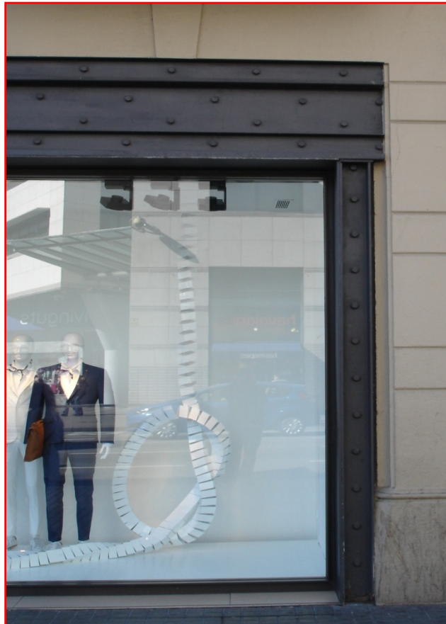
Figura 2.19 Exemple d'unió cargolada. Autoria personal.
