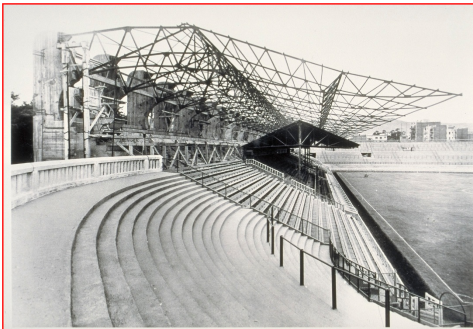
Figura 2.37 ETM-284. Tribuna cubierta del Campo de fútbol de Les Corts. Barcelona. Font: Archivo Torroja.
