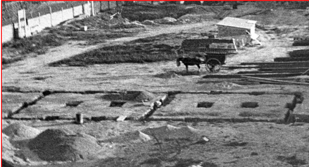
Figura 2.31 Rases per realitzar els fonaments. Casa Bloc 13 .
