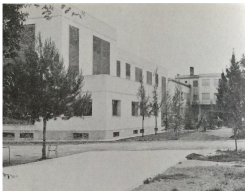
Figura 17. Nuevo Pabellón de ingresos.
