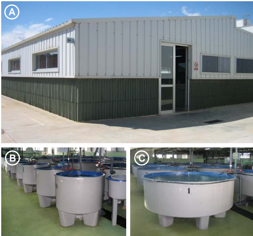
Figura 4.16. Instalaciones de cultivo del grupo de Nutrición y Endocrinología del Crecimiento de Peces del Instituto de Acuicultura de Torre de la Sal (A). Tanques de cultivo de 500 (B) y 2500 (C) litros usados en las diferentes experiencias.
