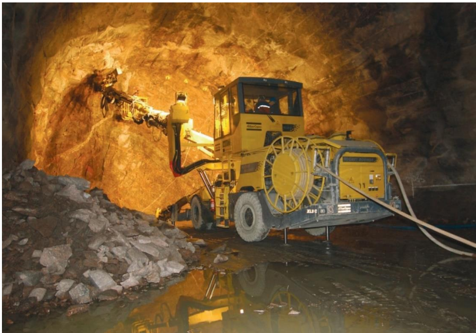
Figura 2. Equipos de Perforación en Desarrollo de Túneles.
