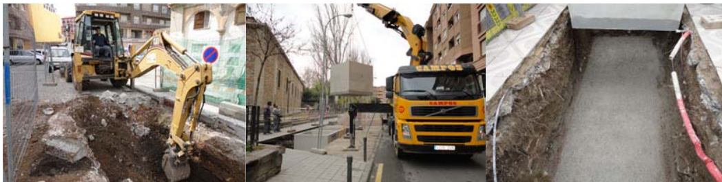
Figura 16 Preparació del fossat
