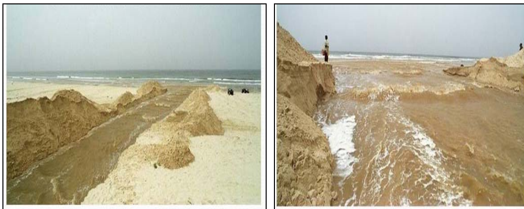
FIGURA 27. Situación inicial y dos días después de la apertura del canal de la Lengua de Barbarie (2003)
