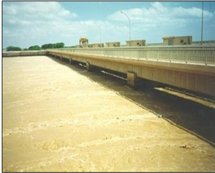
FIGURA 25. La presa antisal de Diama
