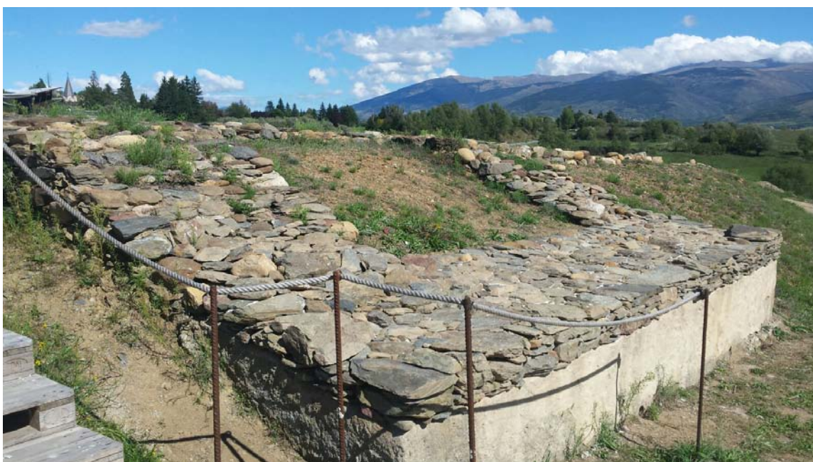
Imatge d'una de les torres un cop feta la consolidació i restauració
