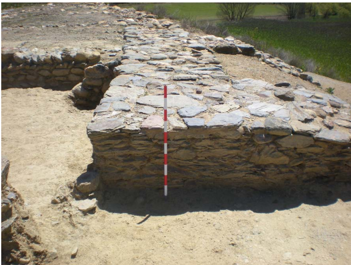
Brancal de l'entrada on s'observa, a la cantonada, el possible suport de muntant ue 369
