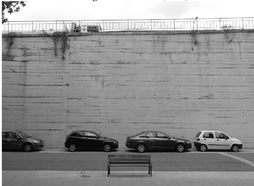
Figura 39. Detall del mur de cobriment de les vies ferroviàries al seu pas per l'avinguda Meridiana (2015)
