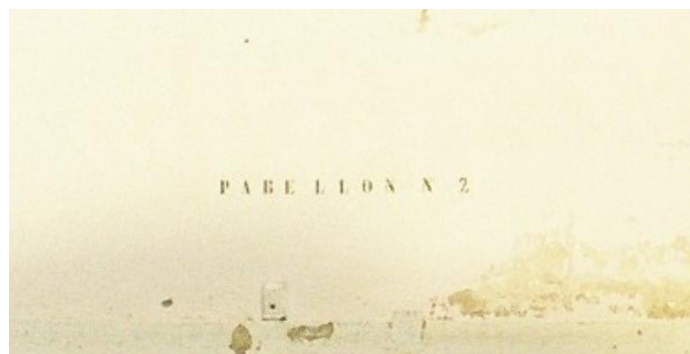
Foto 3. Detalle leyenda pared frontal "Pabellón N°2"
