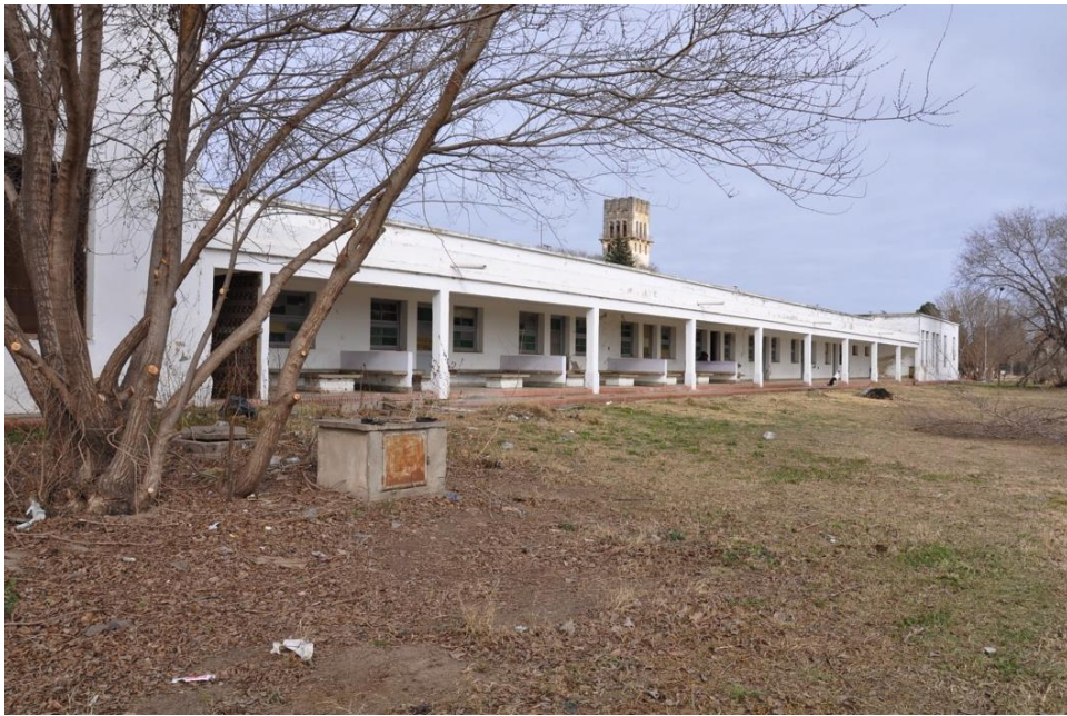
Foto 1. Vista galería lateral izquierdo
