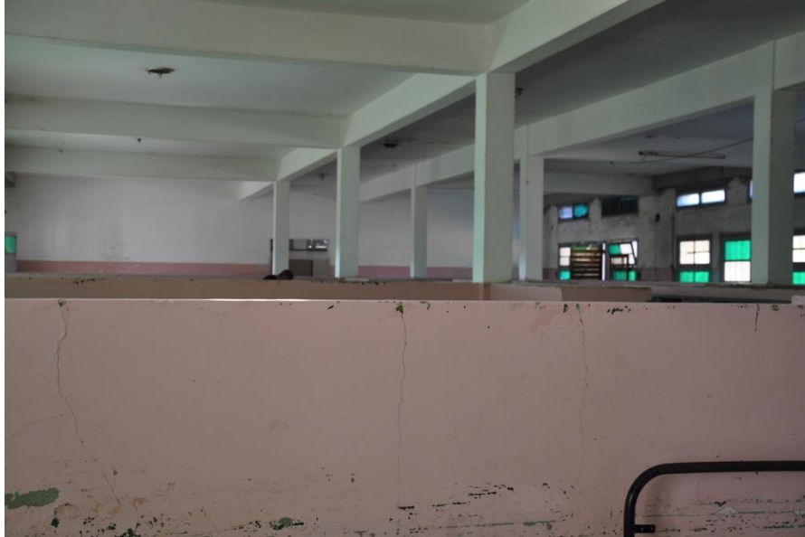
Foto 6. Muros media altura
