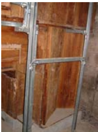
Figures 390 et 391 : étais situés au niveau du socle et de la travée latérale gauche du retable.
