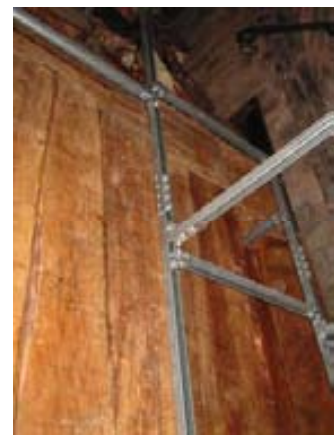
Figures 390 et 391 : étais situés au niveau du socle et de la travée latérale gauche du retable.
