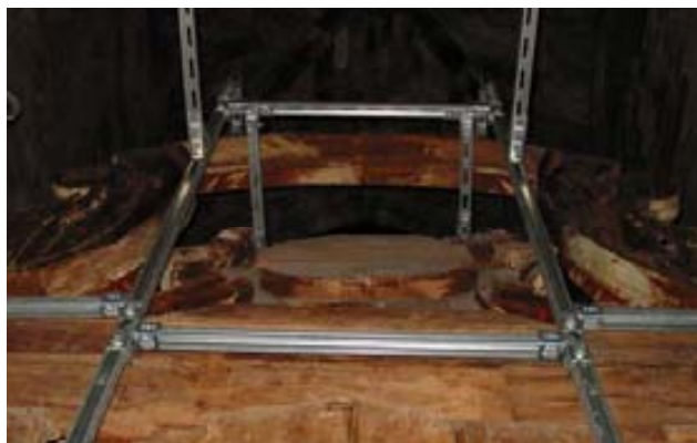
Figure 392 : étais de maintien de l'attique.
