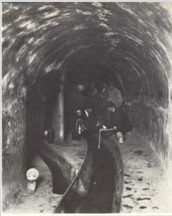
IMATGE 55 INTERIOR D'UNA GALERIA DEL CLAVEGUERAM DE BARCELONA AL 1903 214
