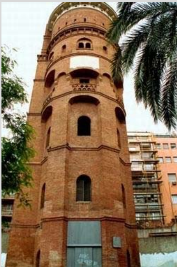
IMATGE 13 TORRE D'AIGÜES O "TORREÓN" DE L'EIXAMPLE
