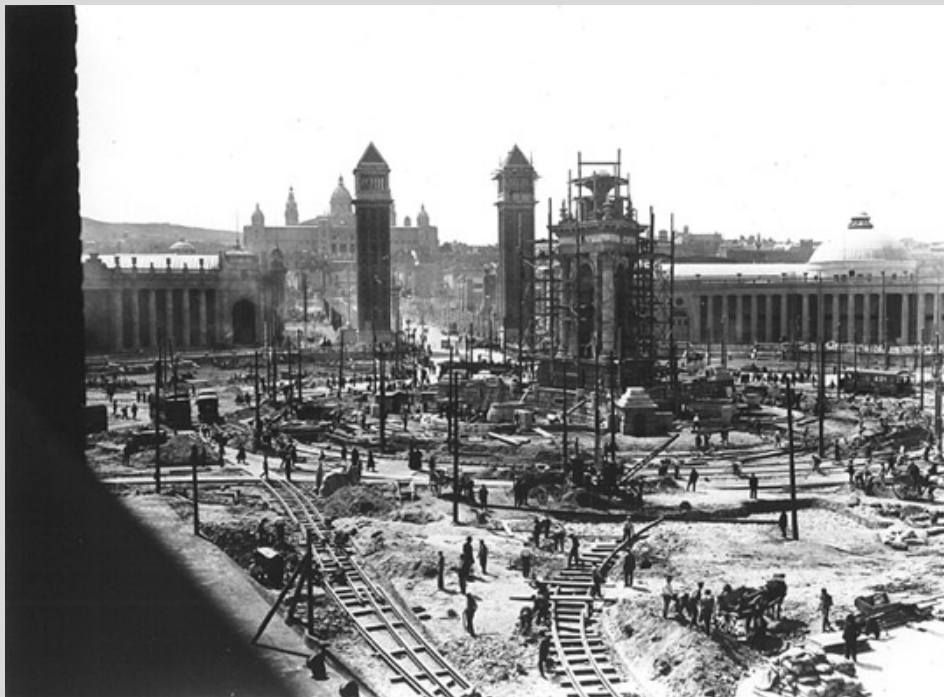
IMATGE 69 OBRES DE CONSTRUCCIÓ DE LA PLAÇA D'ESPANYA EL 1928 448
