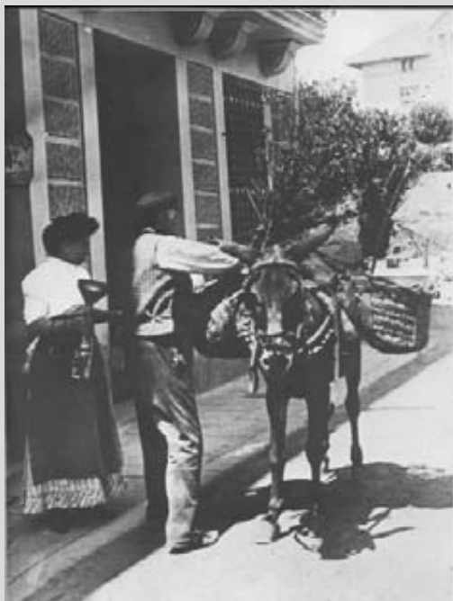
IMATGE 8 REPARTIMENT D'AIGUA DE LA FONT DEL FERRO 21
