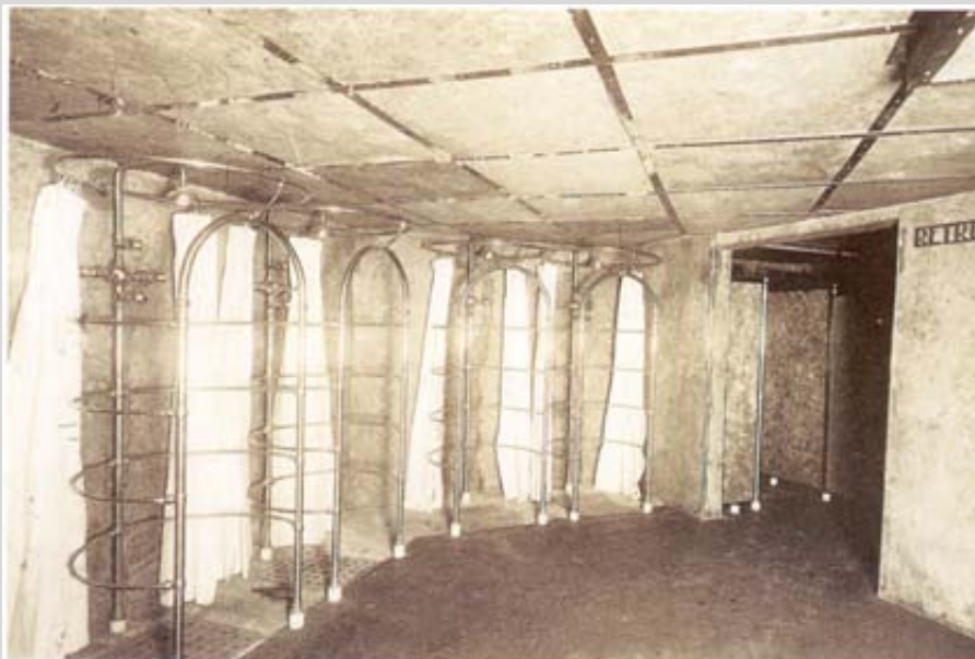
IMATGE 70 DUTXES PÚBLIQUES SUBTERRÀNIES DE LES TERMES MUNICIPALS A SOTA DE PLAÇA D'ESPANYA EL 1929 454
