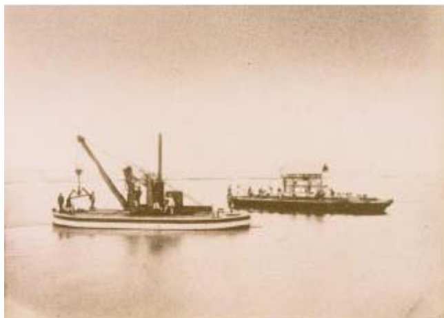
Grua de vapor de 10 Tm i Ganguil de fusta amb pou central a Manila. Font: El imaginario colonial: 1521-1945 pp 46
