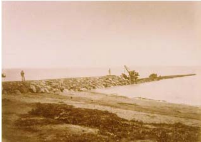
Obres d'ampliació del dic de l'Est al port de Manila.
