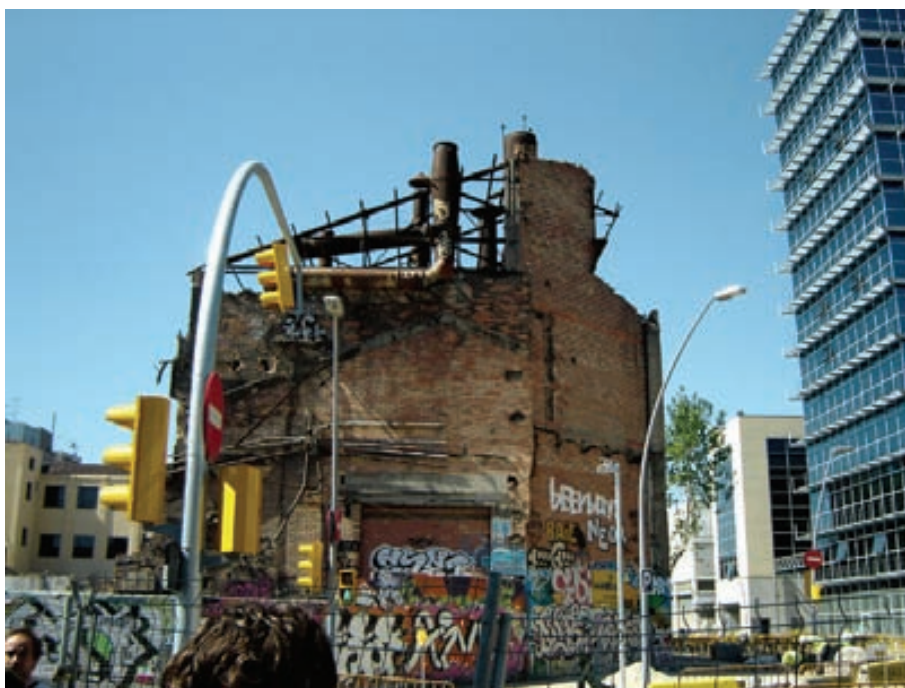
Imagen 3: La fábrica anterior demolida, marzo de 2008.
