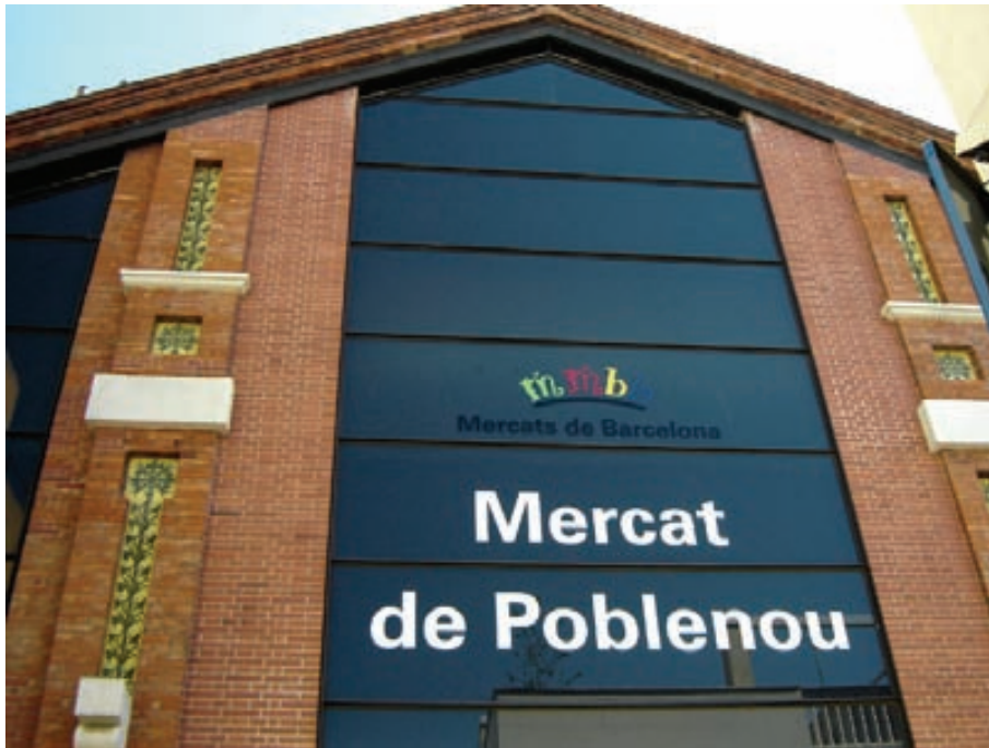
Imagen 4: Fachada del Mercat de Poble Nou. Construido en 1889. Rehabilitado entre el 2004-2005.
