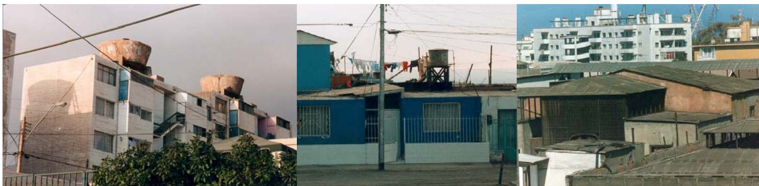
Fig N° 277a Imagen de las cubiertas de los edificios de Antofagasta (1)Estanques de agua (2) tendedores, (3) sombreaderos.
