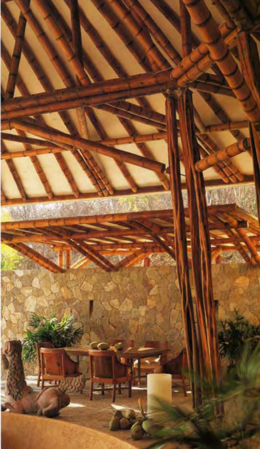
36. Estructura madera y guadua S.Vélez Construcción típica para el secado del café
