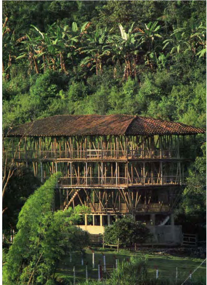
36. Estructura madera y guadua S.Vélez Construcción típica para el secado del café
