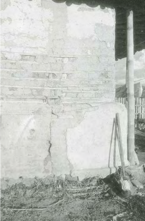
44. Muro de tapia pisada
