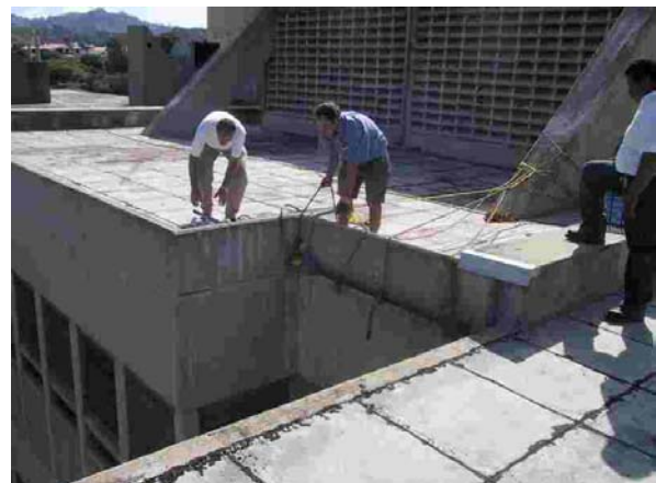
Fig. 12.8.b. Detalle colocación del gato hidráulico
