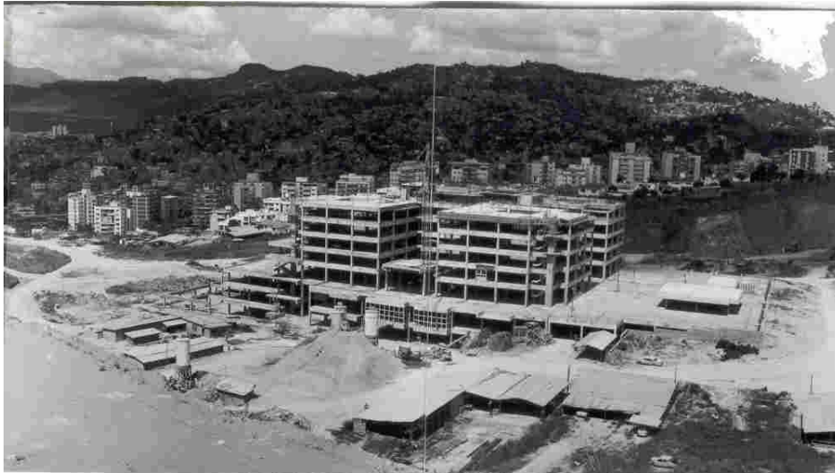
Fig. 12.22. Vista general de la estructura del Hospital, en fase constructiva (año 1975)
