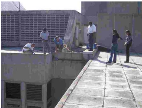
Fig. 12.8.a. Colocación del puntal metálico entre edificaciones adyacentes
