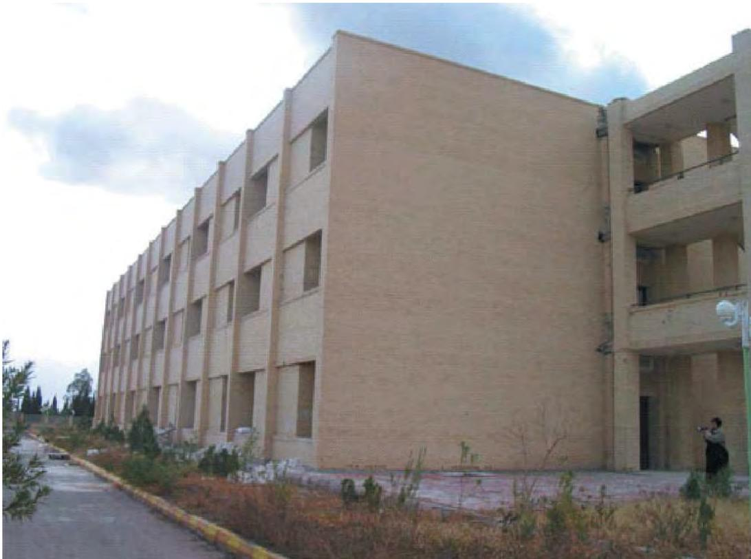
Figura 3.17. Hotel Bam Azadi, con pórtico de acero, no mostró daño estructural (Tomada de Mostafaei y Kabeyasawa (2004))
