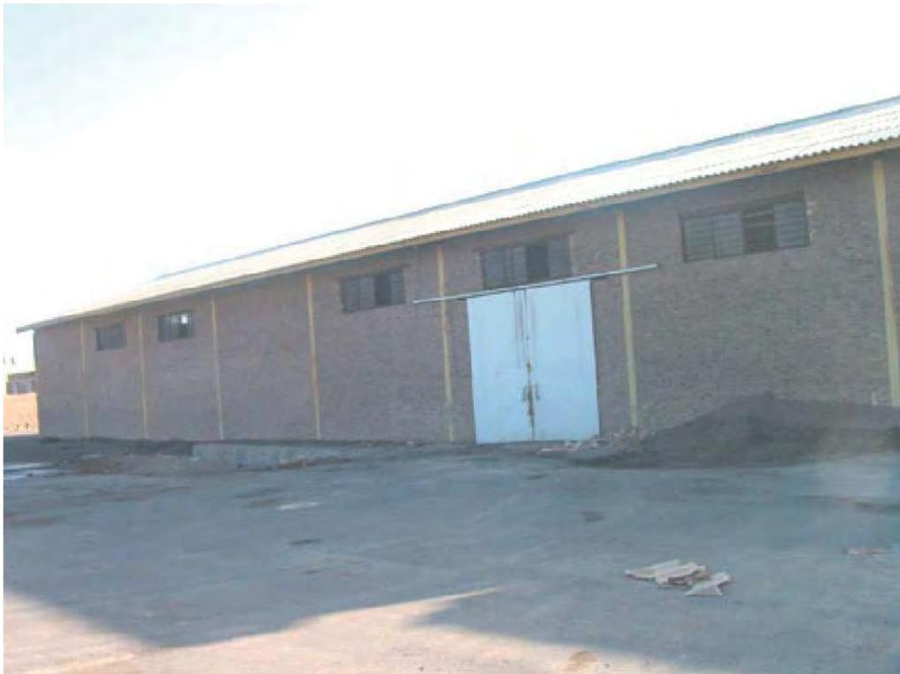
Figura 3.12. Pórtico especial de acero con muros de mampostería, tipo M-S-F.
