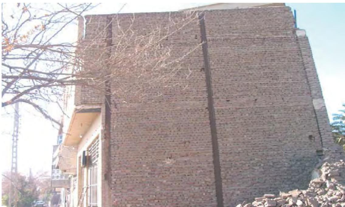
Figura 3.10. Edificación de mampostería reforzada con pórtico de acero, tipo M-S.
