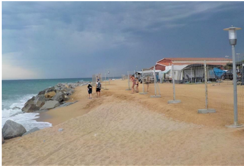
Figura 8. Infraestructura de camping y escolleras de protección en Malgrat de Mar.
