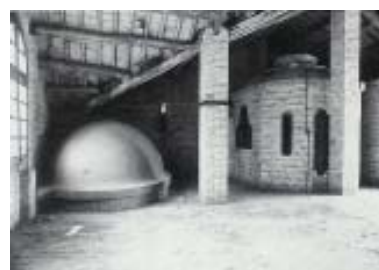
Desván de la Casa Negra, 1915-1926. Se descubren las cúpulas falsas de la escalera y del oratorio.
