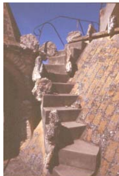
Recorridos por la cubierta.
