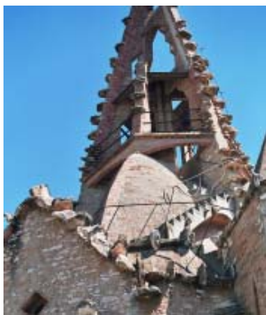
Uno de los seis pilares se apoya en la bóveda.
