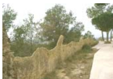
Muro fabricado con somieres en el Santuario de Montserrat en Montferri, 1926-1930.
