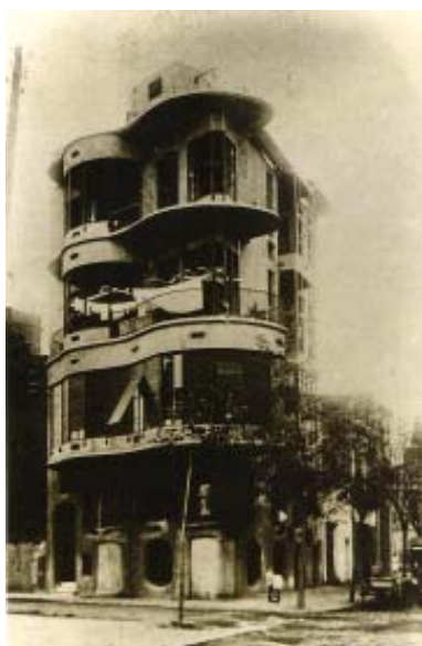
Aspecto de la casa cuando Jujol abandona las obras.
