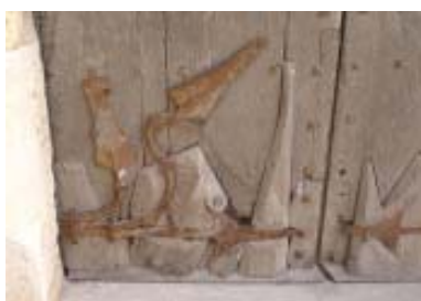
Casa Bofarull, 1914-1931. Detalle de una de las bisagras de la puerta principal.
