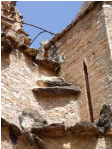
Detalles de la utilización de estas piedras en cada una de las aristas del templo.
