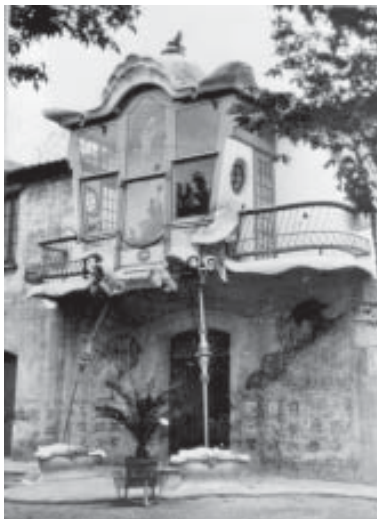
DG-152. Tribuna recién terminada. En esta imagen puede comprobarse que el coronamiento aún no se ha construido.
