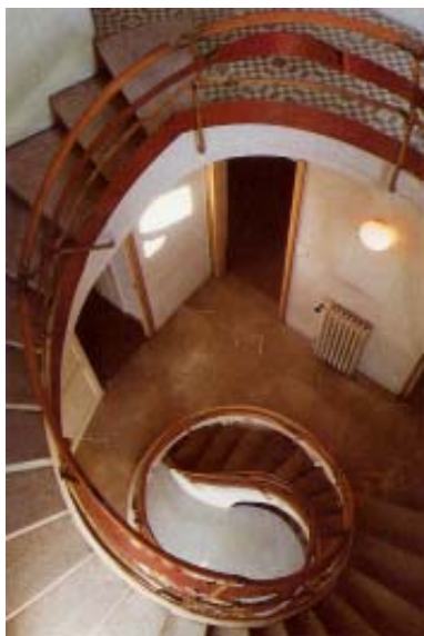
Torre de la Creu, 1913. Escalera: un listón continuo recorre todas las plantas.
