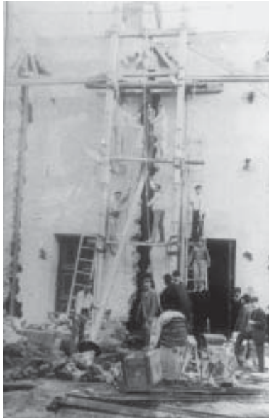
Teatro del Patronato Obrero en construcción. Reutilización de un pilar para el apeo de un muro. 1908. Tarragona. DG-037.
