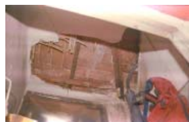
Imagen del envigado a través de un hueco del cielo falso en el segundo piso.
