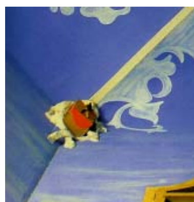
Capiteles de cartón sostienen la cubierta de la escalera de la Casa Negra, 1915-1926.
