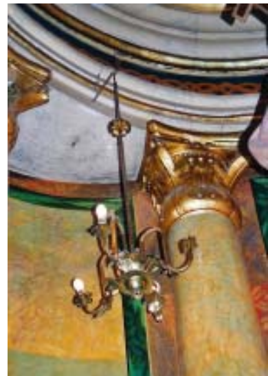
Lámparas en el presbiterio de la parroquia de Bonastre, 1941 - 1942. El sencillo tubo Bergman como material decorativo.
