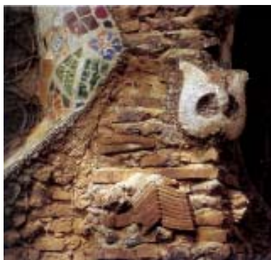
Cripta de la Colonia Güell, 1908-1914. Detalle de los ladrillos recocidos.
