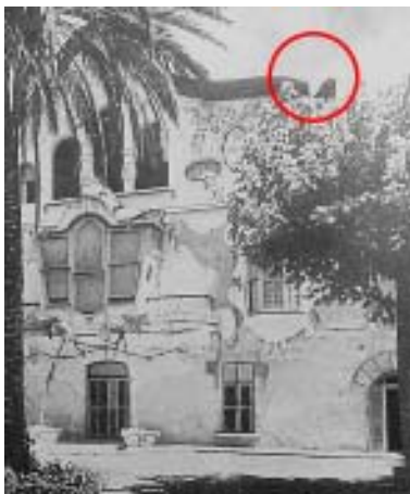
DG-155. Coronamiento y cubierta terminada. En la parte derecha de la imagen puede comprobarse que la cornisa aún no se ha prolongado en su totalidad.
