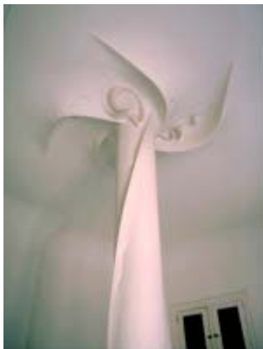
Casa Planells, 1923. Detalle del pilar en el piso principal.
