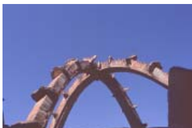
Arcos con dovelas en los lavaderos de la Casa Bofarull, 1914-1931.
