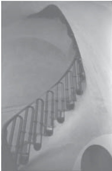
Ascenso de la escalera en el tramo que va del entresuelo al piso principal.
