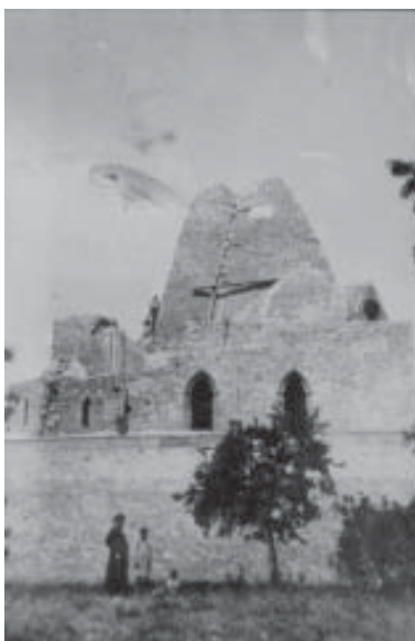
DG-241. Imagen de las obras. Vista de las bóvedas centrales ya terminadas, 1920-1922.
