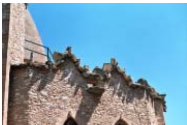
Detalle de cornisa en la fachada suroeste del templo. Las piedras definen el perfil.
