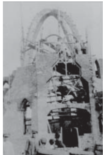
DG-238. Imagen de las obras. Arcos parabólicos principales terminados, 1919-1922.
