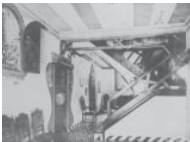
DG-164. Cuerpo de la escalera en planta baja.
