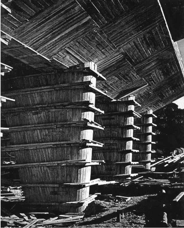
Moldes e impresiones en madera sobre béton brut en la Unité, FLC L1.13.81. Foto de Renzis.
