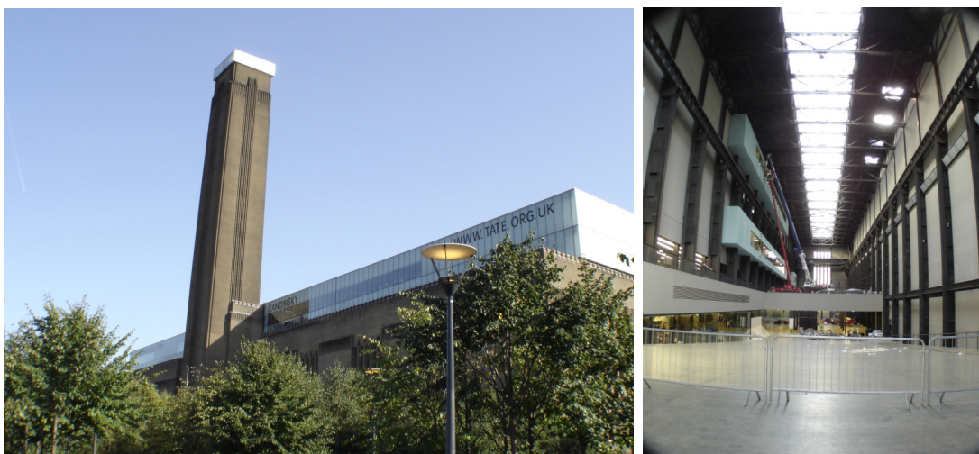
Fig. 4 y 5. Museo Tate Modern, Londres. Antigua central eléctrica convertida en museo de arte. Vista de la chimenea de la antigua central desde el exterior e interior de la antigua sala de turbinas. El Museo tiene actualmente una gran afluencia de público, tanto por la colección que alberga como por el edificio contenedor.
