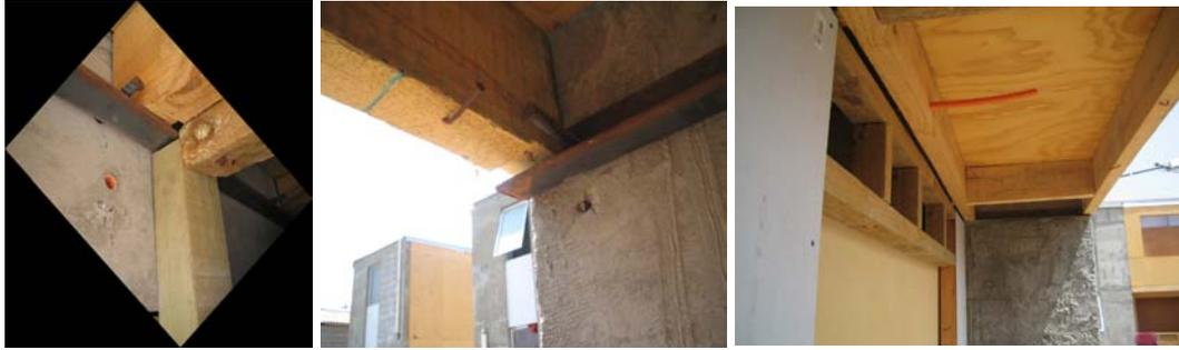
Ilustración 9: Envigados entrepiso hombro y perfil metálico, insertos de (fe) estriado en muro de hormigón armado. <sup>10</sup>
