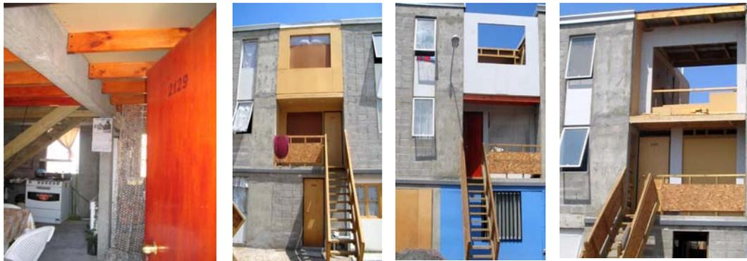
Ilustración 10: Derecha estructura entrepiso ampliado con madera, centro y extremos, ampliaciones proyectadas <sup>11</sup>
