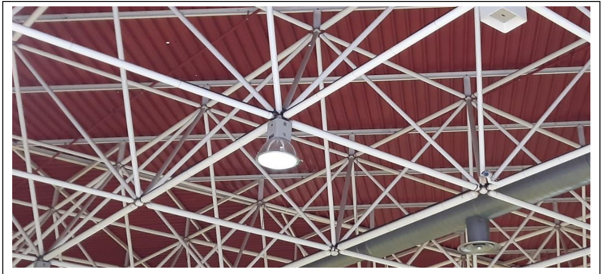
Imagen 1.1.1 Estructura tridilosa del recinto ferial de Cornellà de Llobregat - Barcelona (Propia)
