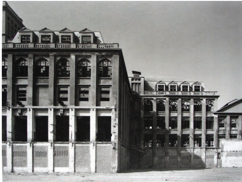
1.13 Recintos industriales: Catex al Poblenou.
