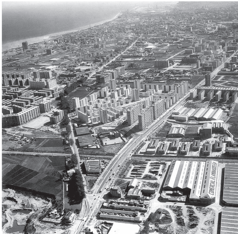
1.80 La calle Guipuzcoa en la confluencia con la calle Pere IV. En primer plano La Pau. 1966.
