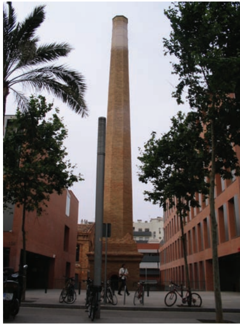
3.54 Chimenea Industrial en la Ca L'Aranyó
