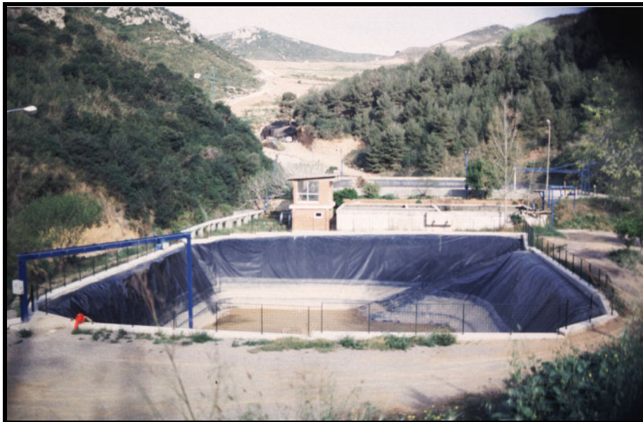
Fig.1.1.8. Imatge de la bassa de lixiviats.
