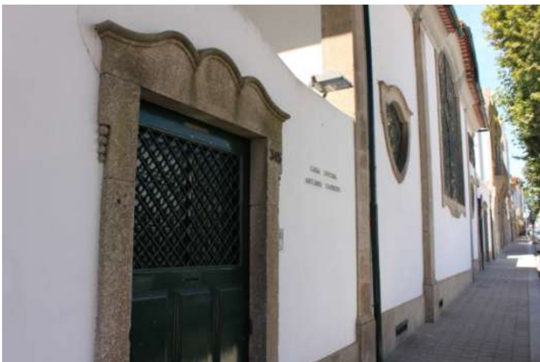
Acceso a la Casa Oficina António Carneiro
