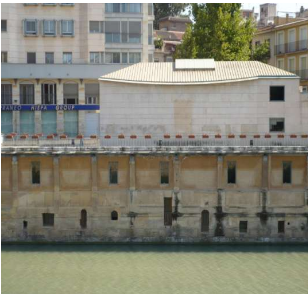
Vista parcial de la fachada norte: biblioteca
