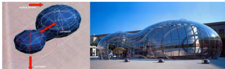
**Fig 30.** Bernhard Franken, The Bubble - Pabellón BMW (1999). Una simulación informática con la interacción de dos gotas de agua fue utilizada para crear esta forma.
