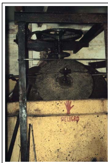
Ilustración 77. Rudimentaria señalización de peligro
