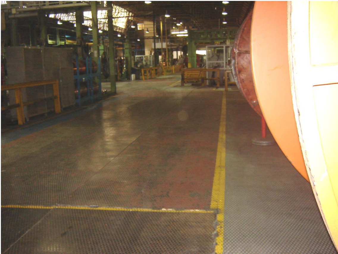
Passadís entre línies de vulcanització.
