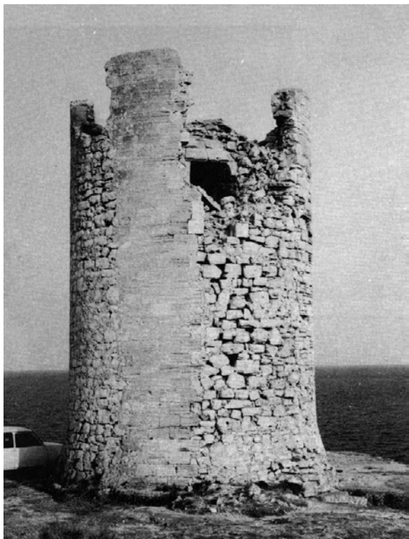
Fig. 2.34 La Torre d'en Beu (Santanyí). Imatges posterior (González de Chaves, 1986) i anterior a la intervenció que patí a la dècada dels setanta. Observi's com les carreuades de marès estaven ben conservades.
