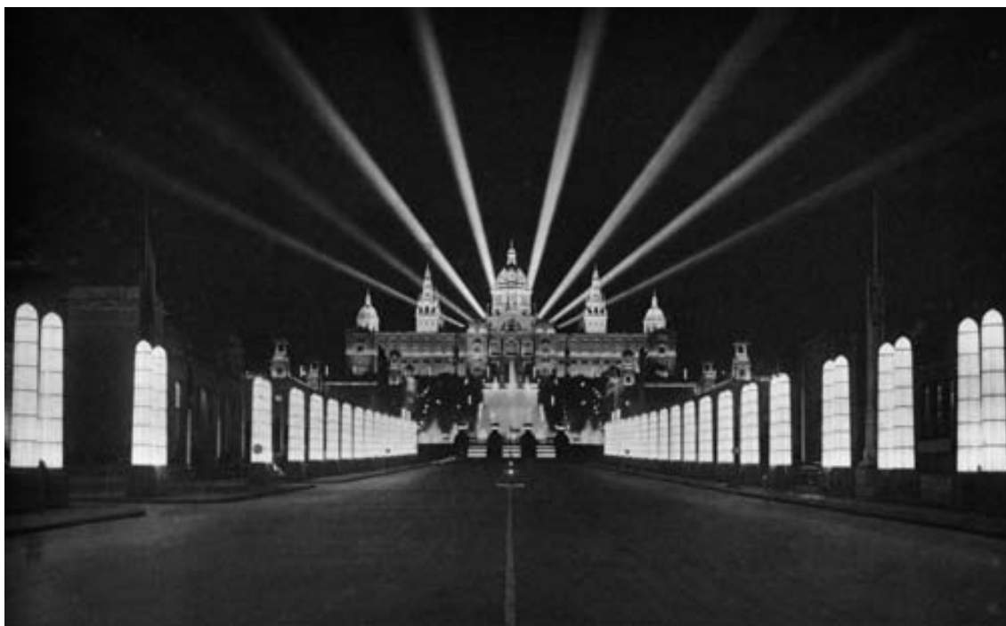
Figura 2.1. Espai principal de l'Exposició, amb la Font Màgica i el Palau Nacional al Fons. L'espectacle de llum i aigua que es va instal·lar a l'espai principal de l'Exposició sota la direcció de Carles Buigas es convertí en el principal atractiu de l'Exposició Internacional de Barcelona de 1929, a més d'ésser considerat un exemple a seguir per a les exposicions posteriors. Font: Exposición Internacional de Barcelona (1929). Gran Álbum Fotográfico . Concesiones Gráficas. Barcelona: Ediciones DEO S.A., s.p.
