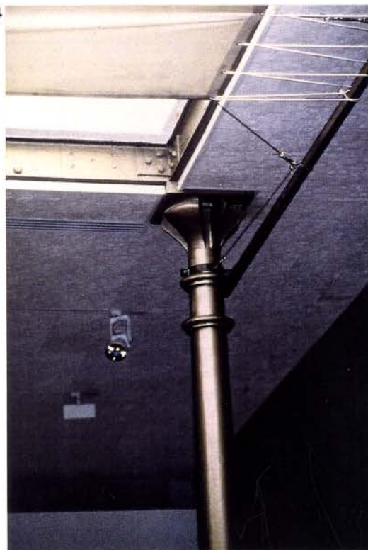
Foto 4 Capitell d'una columna de fosa de l'interior del primer pis, a la cantonada del cel obert, amb l'espai massissat entre les dues carteles.
