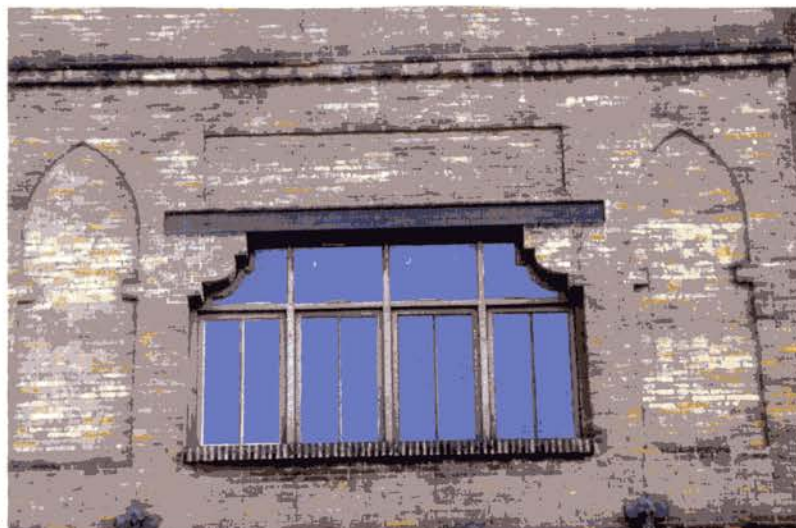
Foto 3 Finestra de la façana est, amb la utilització del maó i ferro vistós (mur i llinda).
