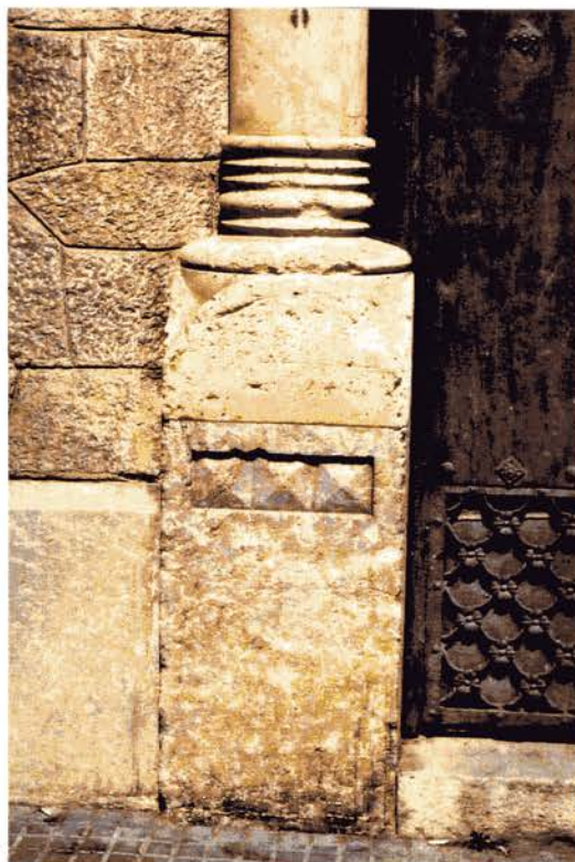
Foto 6 Columna de la balustrada de la part posterior de la casa, que suporta el balcó del pis principal. Reclzada sobre pedestals, amb fust llis i capitell vegetal.
