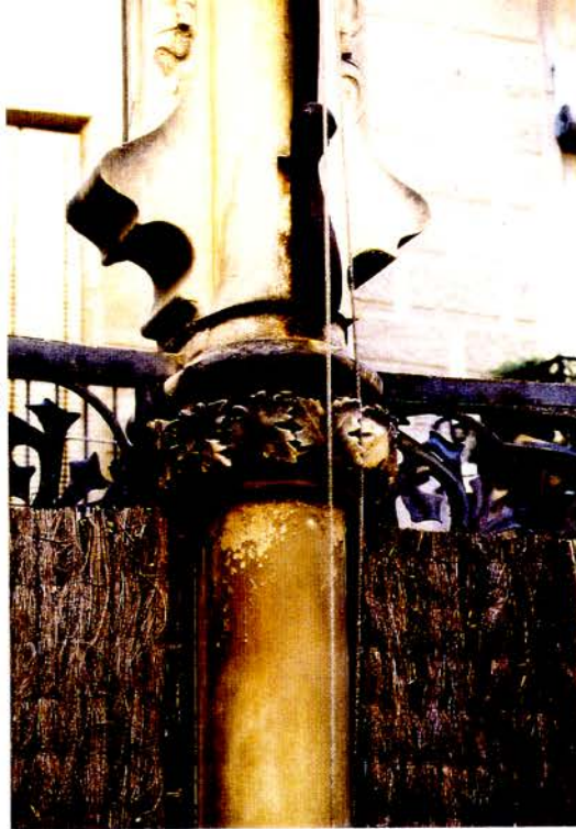
Foto 9 Detall d'una de les columnes del pati interior del pis principal que dona a la façana lateral. Per la part de dins es veu el capitell de fulles de plàtan.
