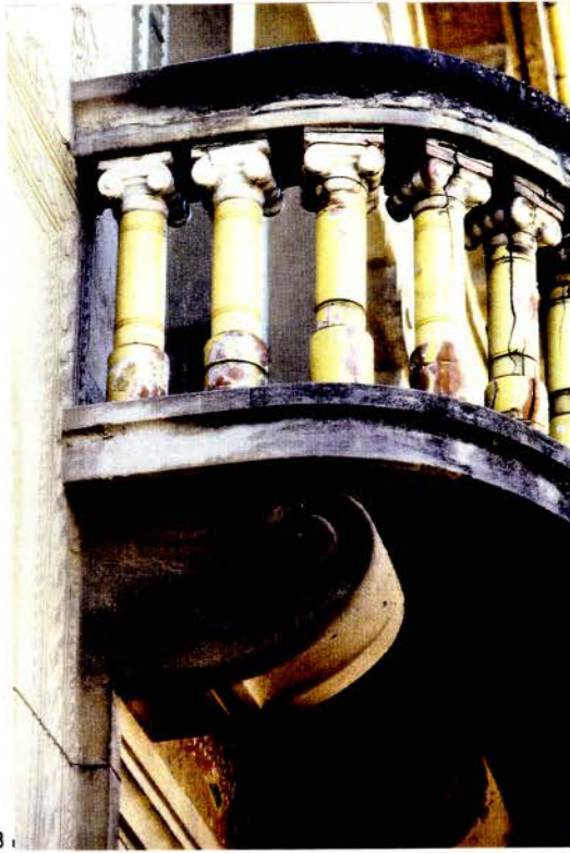
Foto 3 Detall de la balustrada del balcó principal a la façana interior, que consisteix en una sèrie de columnetes jòniques amb capitell de porcellana. Aquest balcó descansa sobre grans mènsules de pedra amb volutes
