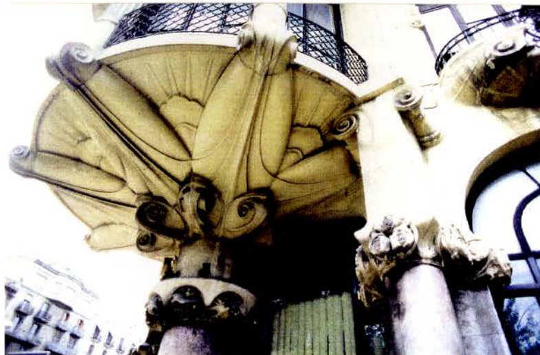
Foto 12 Detall del recolzament de tribuna del primer pis de la cantonada sobre mènsules decorades, sobre la columna de la planta baixa, el capitell, de la qual ja no té funció estructural, i està decorat molt detalladament amb una successió d'ocells i nius.
