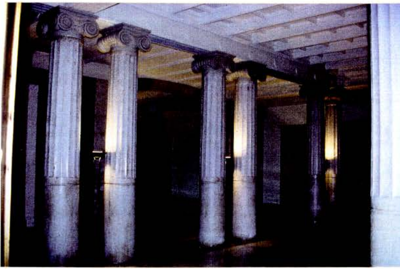
Foto 9 Gran espai interior del primer pis de la Casa Fuster travessat per parells de columnes d'estil jònic que suporta una jàssera metàl·lica decorada en els costats amb modillons, corresponent a la part noble de l'edifici.
