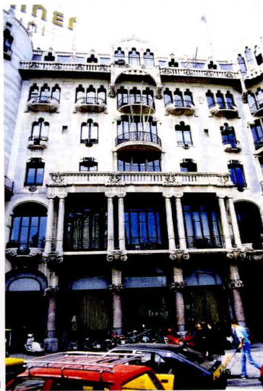
Foto 1 Façana de la Casa Fuster que dóna al Passeig de Gràcia, on destaca la volumetria de la tribuna del primer pis.
