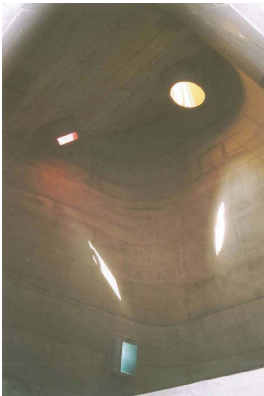
Figura 71. Foto del estado actual de la Iglesia Saint-Pierre de Firminy-Vert, tomada en marzo de 2007. Fuente: MCHS.
