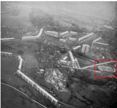
Figura 45. Fotografía aérea del lugar de ubicación de la Iglesia dibujado por Le Corbusier, con los inmuebles Sive-Roux en construcción, en los años sesenta. Fuente: Urbanisme. Revue Française . Firminy. 1968, núm. 104, p.14.
