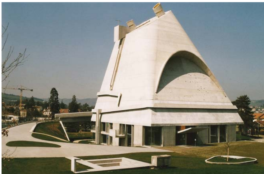
Figura 70. Foto del estado actual de la Iglesia Saint-Pierre de Firminy-Vert, tomada en marzo de 2007. Fuente: MCHS.
