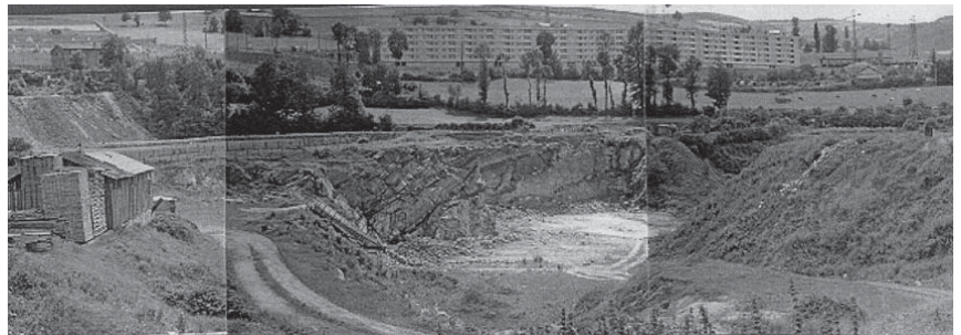
Figura 35. Imagen del solar con vista hacia el este. FLC. X2233
